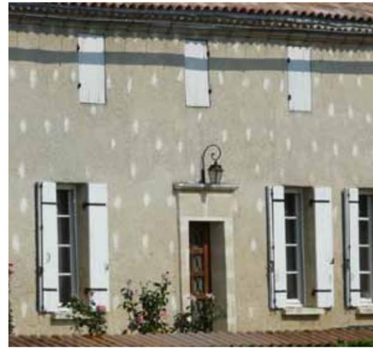
Des façades défigurées par les coffres des volets roulants, par la modification inadaptée des ouvertures, les enduits...
