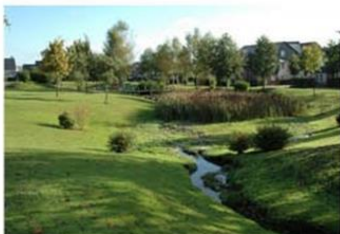
Noüe et bassin d'orage - ZAC Portes de la forêt Bois-Guillaume - CAUE 96
