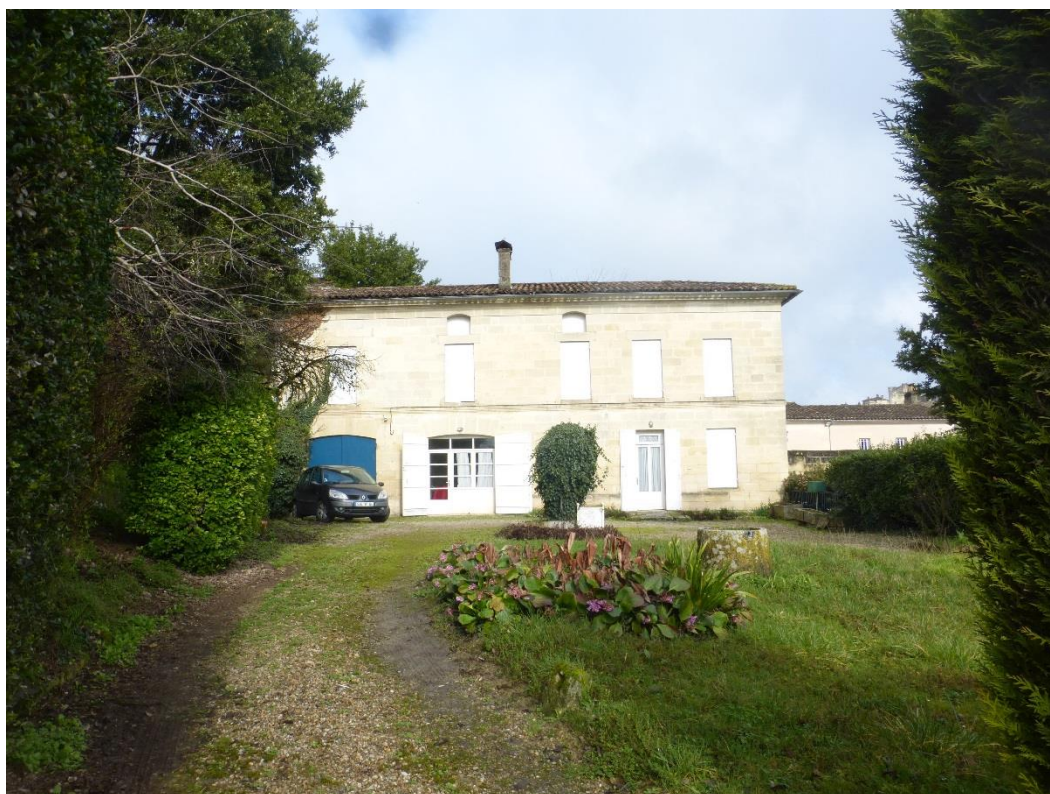
Façade sud de l'immeuble à conserver et à mettre en valeur. Cour à réaménager.
