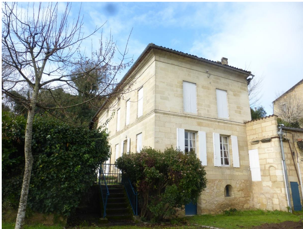
Angle façades est sur la place et sud sur la cour, de l'immeuble à conserver et à mettre en valeur. Accès piéton à la cour par un petit escalier, à conserver et améliorer.
