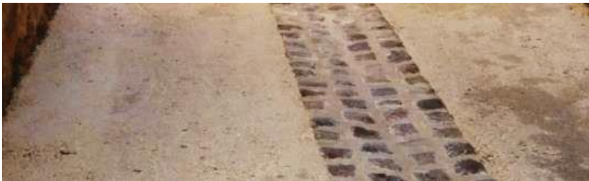
Chaussée stabilisé calcaire, caniveau central petit pavé
