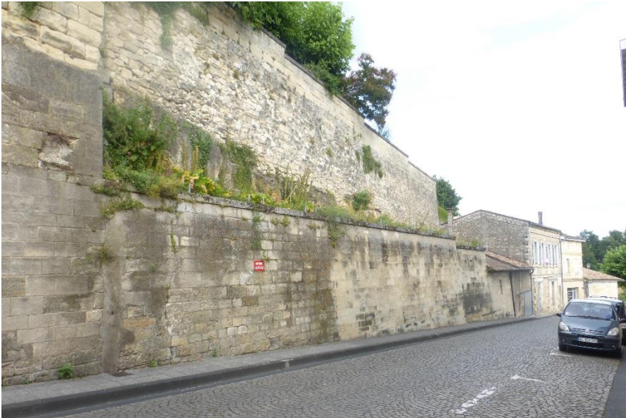
En partie basse de la rue Guadet, les grands ouvrages de soutènement forment une façade sur la rue.
