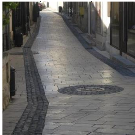
Voie piétonne, accessible PMR, accès véhicules secours et riverains possible
