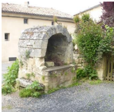
Puits rue porte Brunet (3)
