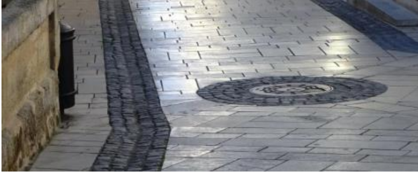
Chaussée dalles calcaire, caniveau latéral petit pavé granit
