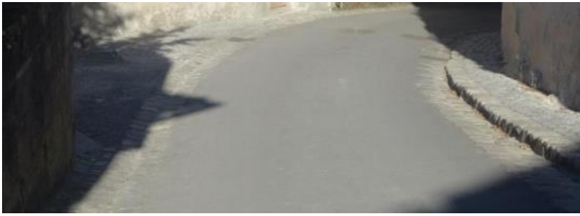
Chaussée bitumée, bordure et caniveau latéral gros pavé ancien (grès dur)
