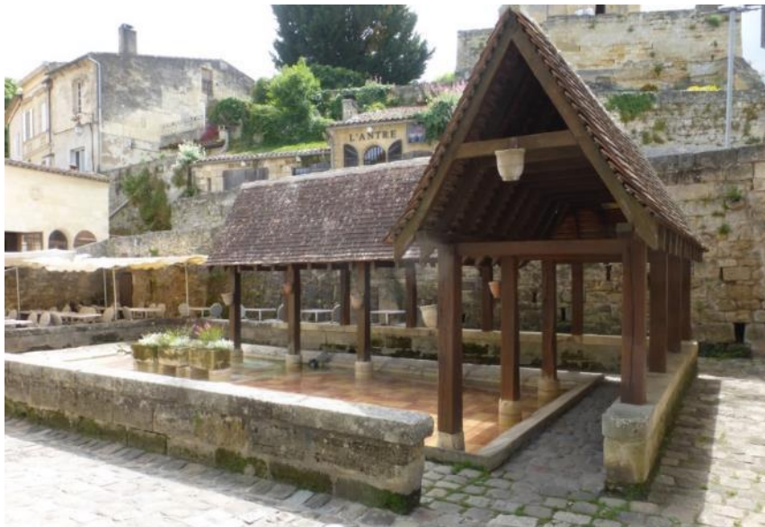
La Grande Fontaine et le mur de soutènement à l'arrière (1)
