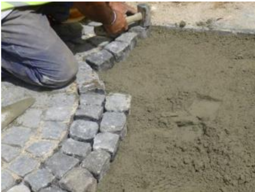
Pose de pavé sur sable
